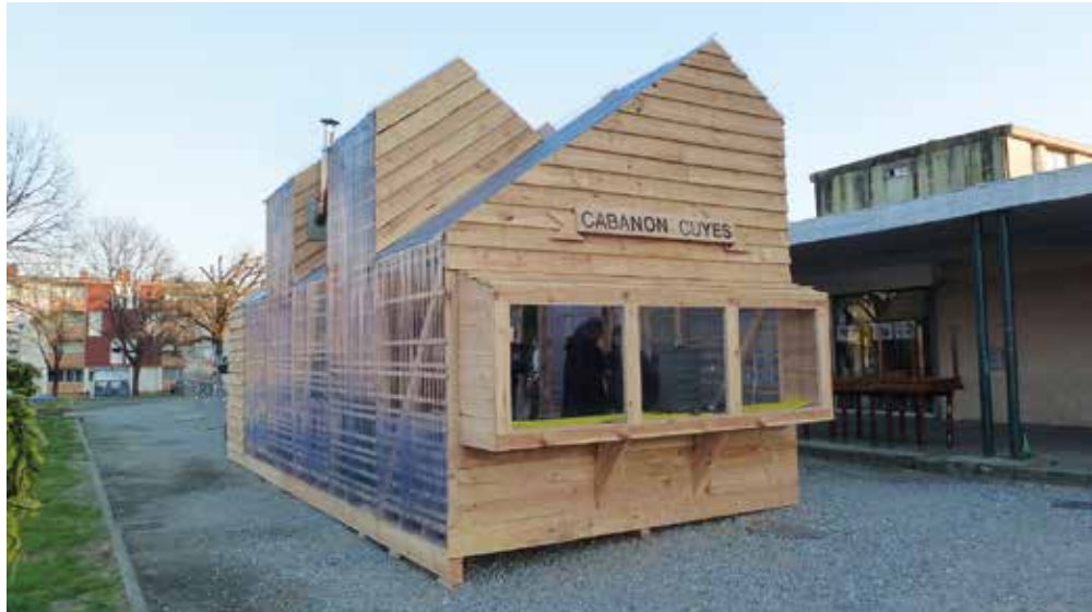
Photographie du cabanon installé. Cabanon Cuyès, Dax, 2013. © Bruit du frigo
