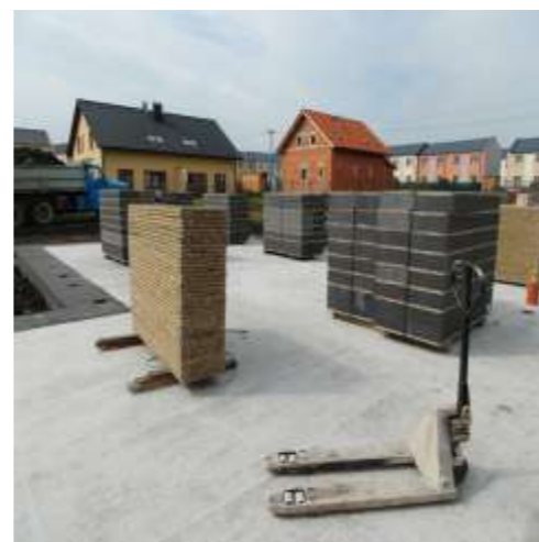
Préparation pour la pose
